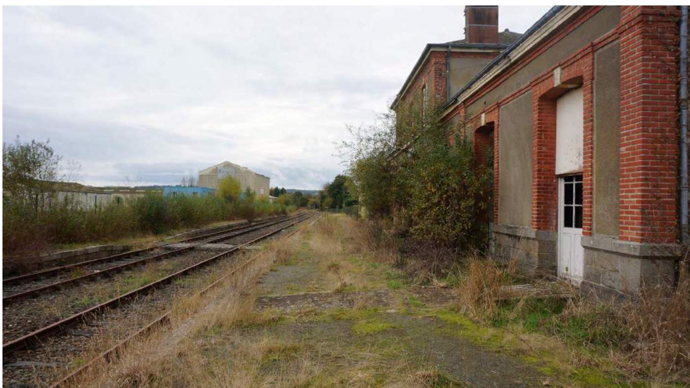
Gare défectée de Saint Brandan
